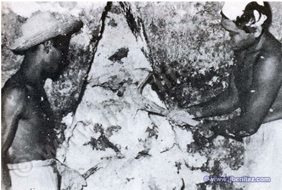
Momento histórico. Los trabajadores se disponen a demoler el núcleo de piedras y cal —todavía húmeda— que cerraba el paso hacia la gran cripta donde iba a ser descubierto el «astronauta» de Palenque.
