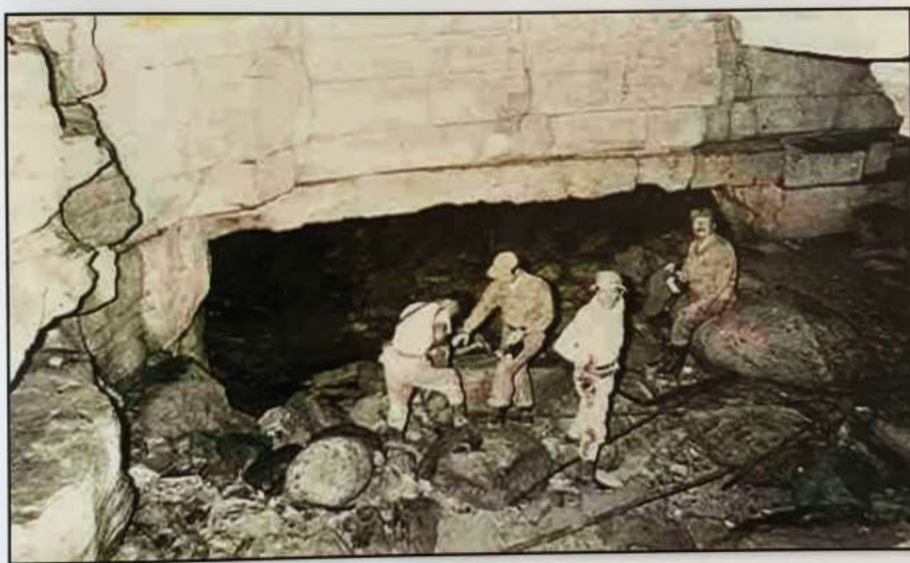
Antes de cruzar el dintel observé que éste está deteriorado por efecto del choque de las piedras contra su arista inferior
