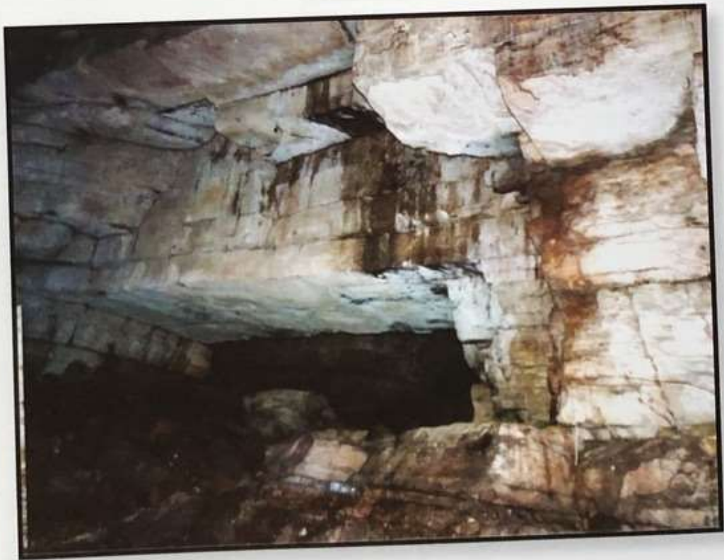
Segundo Dintel subterráneo
