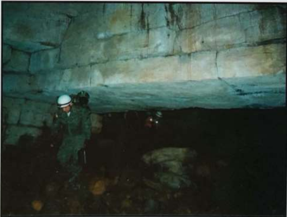
Primer Dintel Subterráneo PUERTA MÓRICZ (cara posterior)
