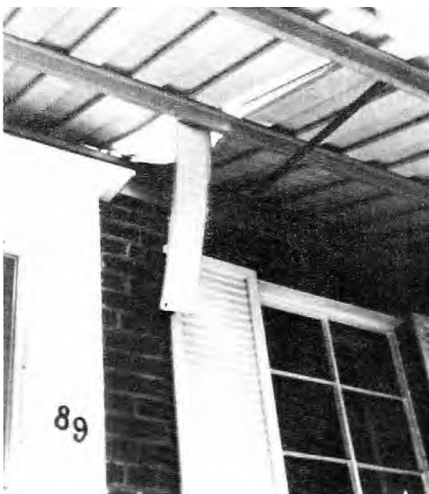
Ésta es la marquesina que resultó dañada por la caída de hielo en la casa del matrimonio Morris, de Washington, D.C. Se desconoce el origen del hielo.
