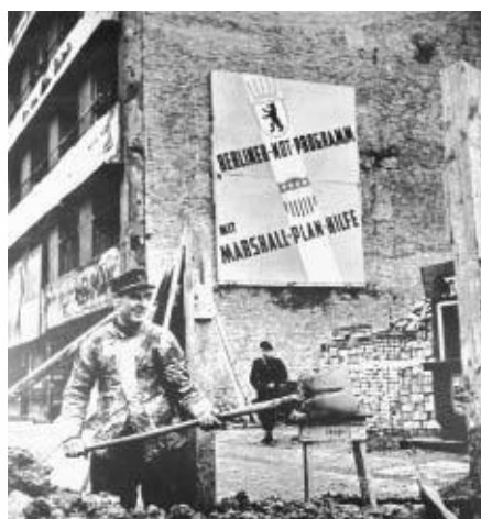
Junio de 1948, operario trabajando en Berlín dentro de un proyecto financiado por el Plan Marshall (según indica el cartel colgado en el muro). Estados Unidos gastó trece mil millones de dólares en la recuperación de Europa entre 1948 y 1952. Con Gran Bretaña, Francia y Alemania como mayores beneficiarios, el plan exacerbó los temores soviéticos de una Alemania rearmada y de verse rodeados por naciones capitalistas.
