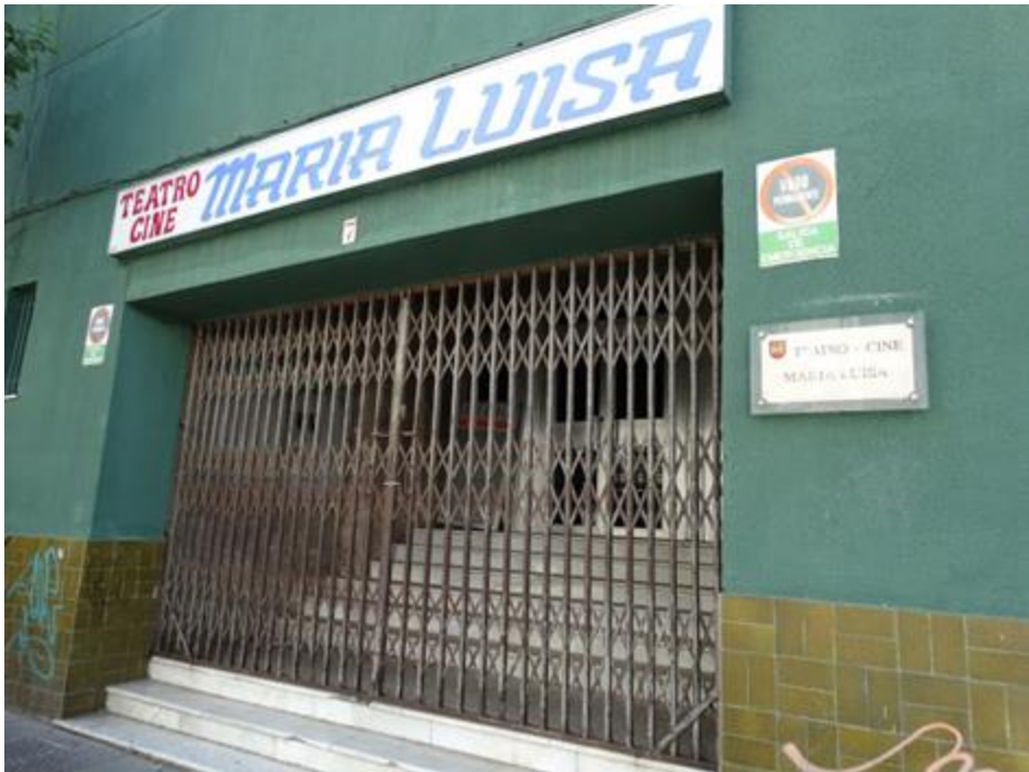
Fachada de la entrada del Teatro-Cine: Maria Luisa, de la localidad de Mérida, España
