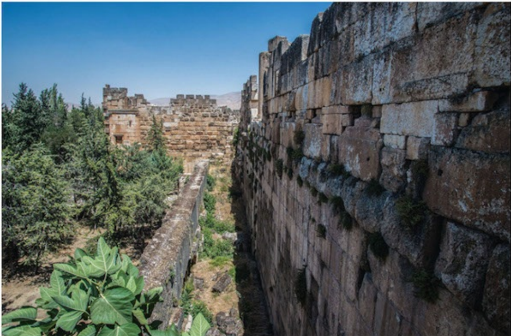
Foto 44. Brazo norte del muro megalítico en forma de U que rodea la plataforma del Templo de Júpiter. Tenga en cuenta el tamaño más pequeño de los bloques con los que se construye la plataforma (lado derecho de la imagen).
