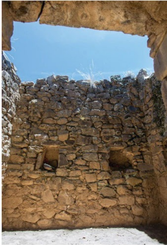
Foto 56. Arquitectura inferior del Templo de las Vírgenes, que se sabe que fue construido por los incas.
