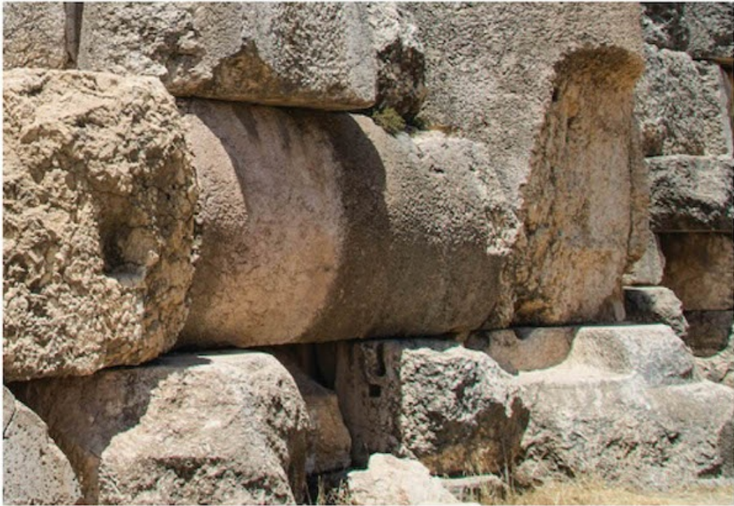
Foto 43. Primer plano del tambor de columna reciclado en el muro de fortificación árabe. Tenga en cuenta que el tambor está perfectamente aplanado en la parte superior e inferior exactamente como el tambor de la columna en los cimientos debajo del trilito. El argumento de que los árabes carecían de la experiencia técnica para cortar y encajar bloques de manera precisa, por lo tanto, no tiene sentido.
