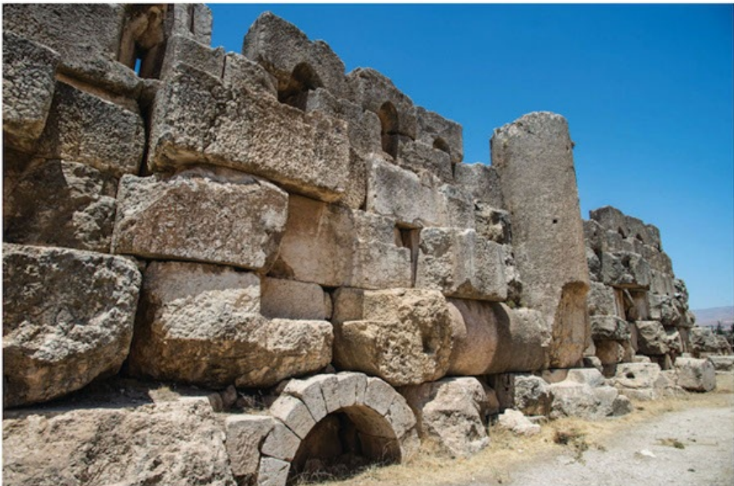
Foto 42. Un muro de fortificación construido por los árabes en Baalbek con materiales romanos reciclados. Observe el tambor de la columna colocado horizontalmente a la derecha del arco.
