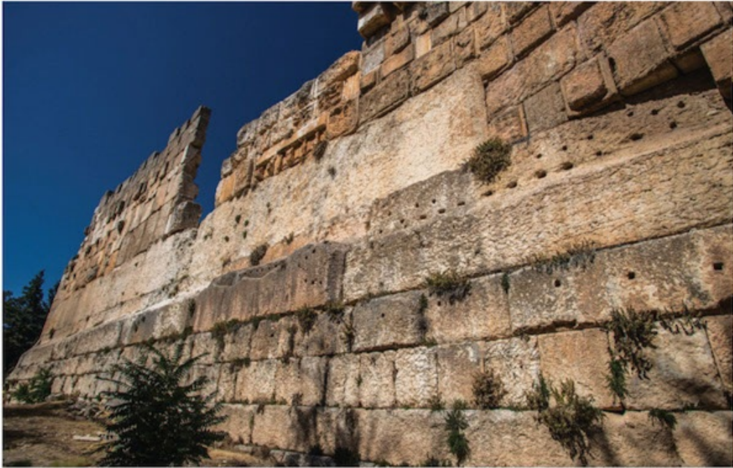
Foto 39. Los tres enormes bloques trilíto en el lado oeste del muro megalítico en forma de U flanquean, pero no tocan, la plataforma del Templo de Júpiter.
