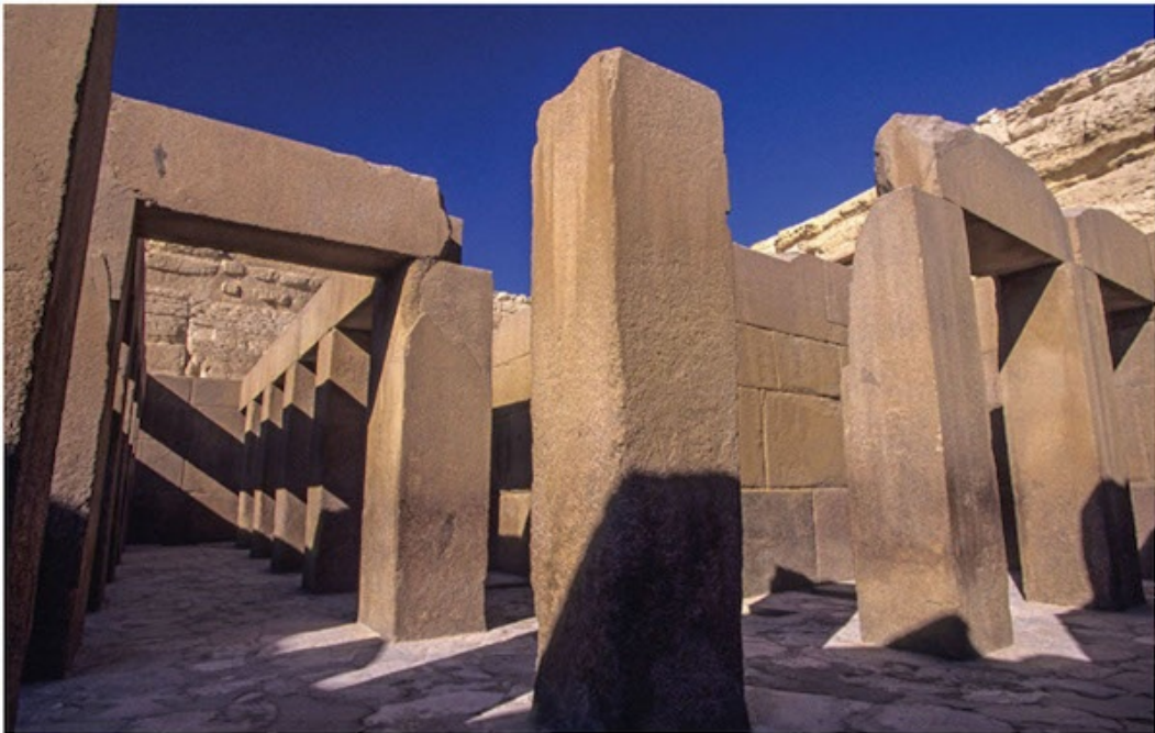
Foto 36. Los elementos de granito del "Templo del Valle" se agregaron en tiempos dinásticos a la antigua estructura de piedra caliza preexistente.
