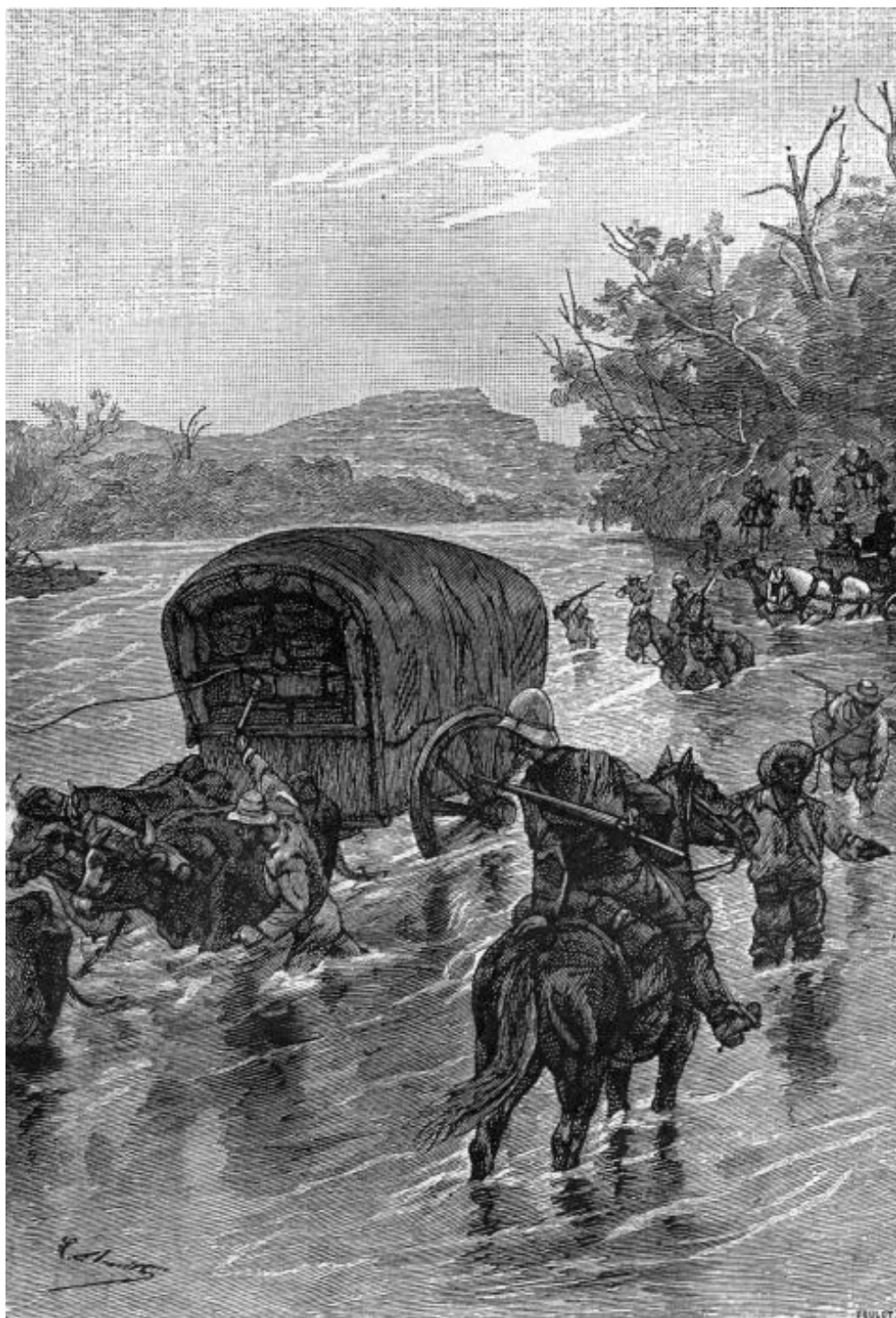
Encontraron un paso que permitió a los coches y carretas transportarse a la orilla izquierda.
