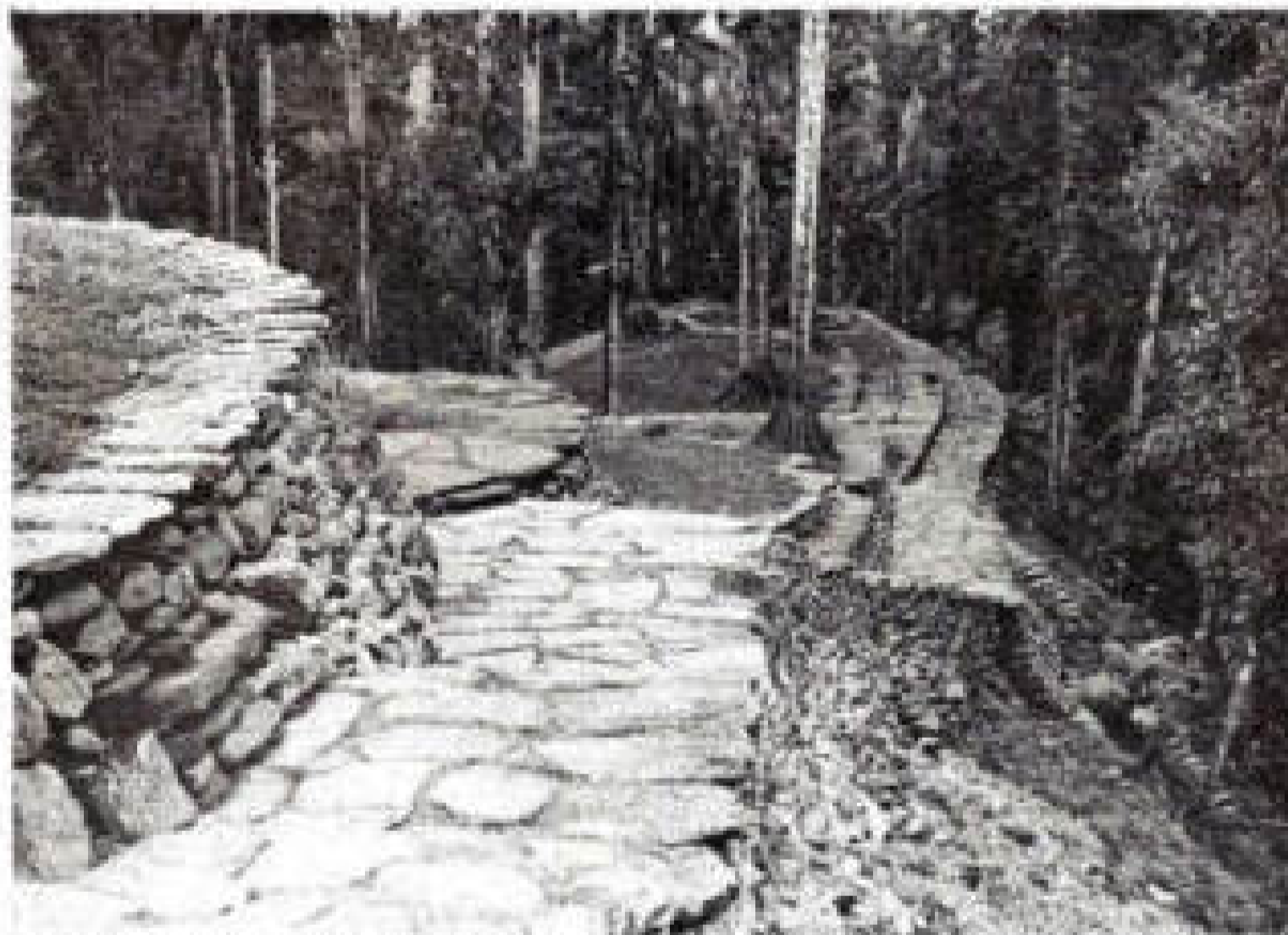
La ciudad perdida de los Tayromas. Centenares de montañas de la Sierra de Santa Marta fueron cortadas en sus lomos a manera de repisas, mediante obras de ingeniería que servían para aprovechar las lluvias.
