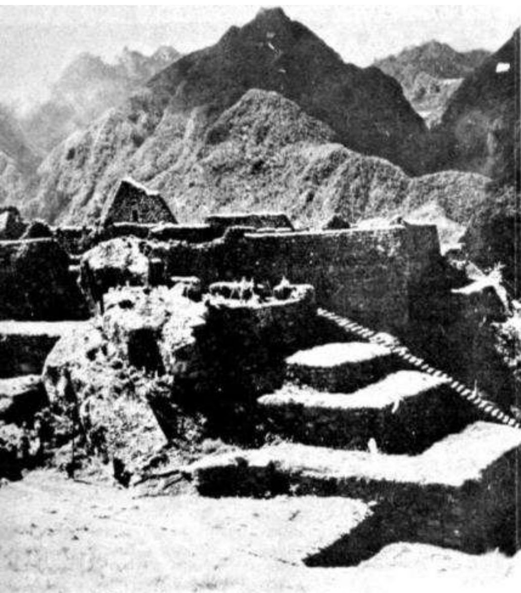
Una planta forrajera africana, el kikuyo, que se extiende con rapidez, está desmoronando ya algunos muros de la "ciudad de las nubes".
