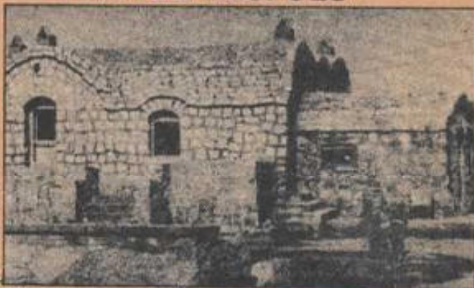
Esta es la casa en donde apareció la confesión al estar siendo objeto de remodelamientos.
