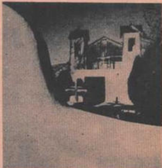
Del interior de esta alieja construcción se viene extrayendo tierra a la que se atribuyen cualidades milagrosas.
